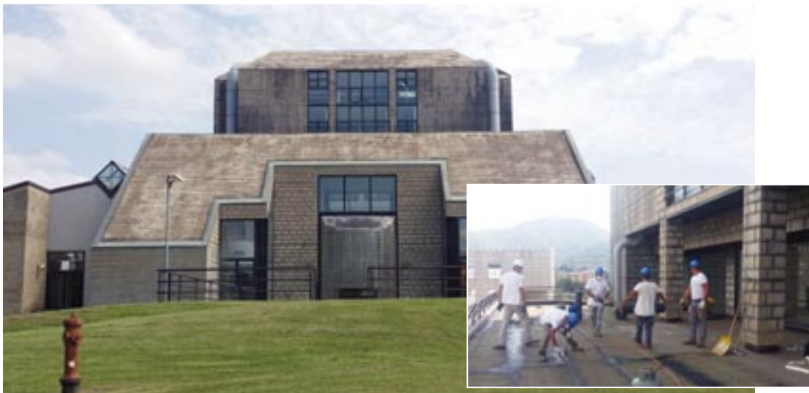
Lavori di ristrutturazione della biblioteca centrale di Ateneo nel campus universitario di Fisciano (SA) Ente appaltante: UNIVERSITA' DEGLI STUDI DI SALERNO (2014-2015)
