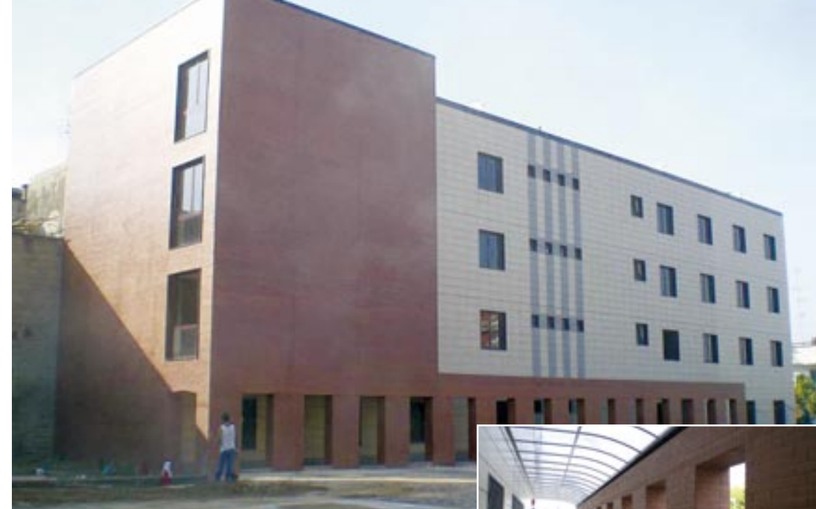
CENTRO PER L'IMPIEGO - MARANO DI NAPOLI (2007-2009) EFFICIENTAMENTO ENERGETICO Ente appaltante: COMUNE DI MARANO Lavori per la realizzazione del Centro dell'Impiego in Via Lazio in Marano di Napoli.
