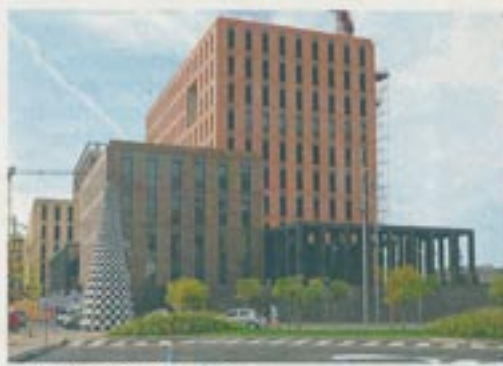
Una veduta del cantiere della Cittadella giudiziaria
