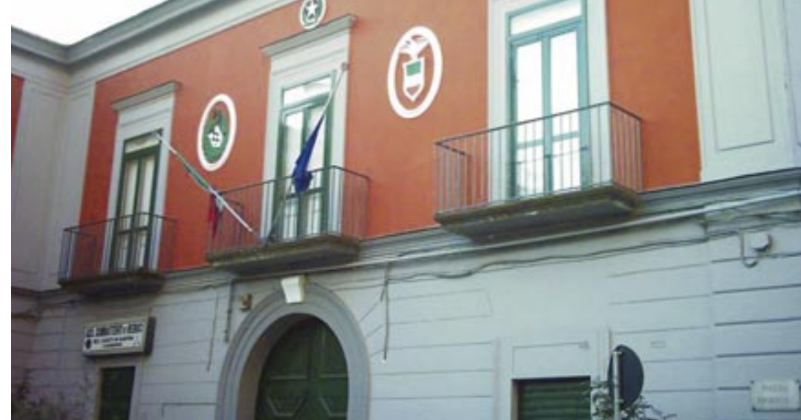
CASA COMUNALE DEL COMUNE DI CASANDRINO (NA) 2002-2003 Lavori di Ristrutturazione e adeguamento sismico della casa comunale, del Comune di Casandrino (NA).
